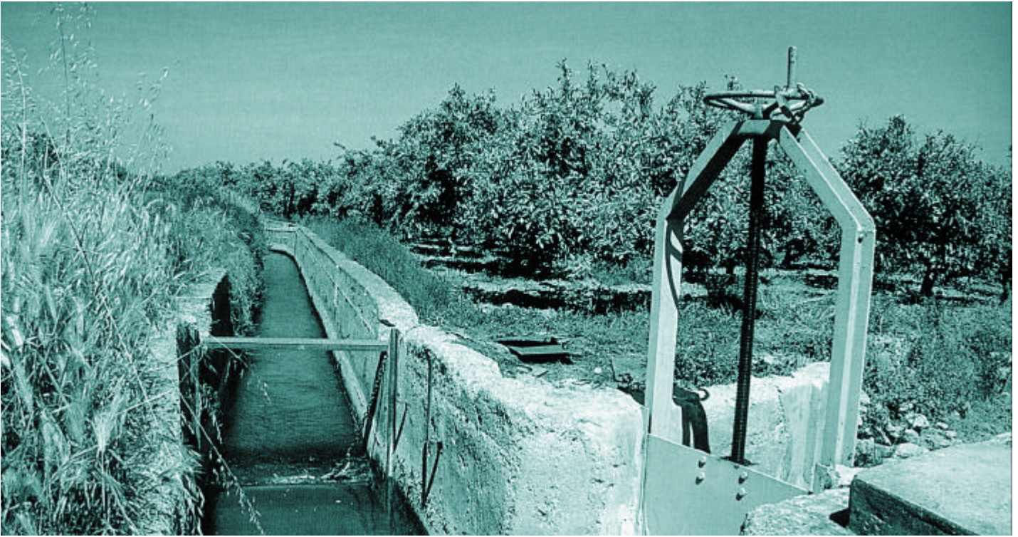
Infraestructuras tradicionales de regadío
